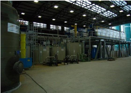
Il fango disidratato in uscita dalla filtropressa viene infine scaricato in un'area sottostante per poi essere prelevato da una pala meccanica e trasportato nell'area di deposito o nell'area di maturazione dei fanghi pompabili, mentre le acque di risulta sono trasferite nelle vasche di sedimentazione delle acque di processo in attesa di essere conferite all'impianto chimico-fisico.
