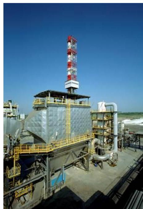
In ultimo, i fumi sono sottoposti a depurazione in un filtro a maniche. Ai fumi in ingresso al filtro viene addizionato con continuità un reattivo in polvere costituito da una miscela di carbone attivo e calce idrata, che,
