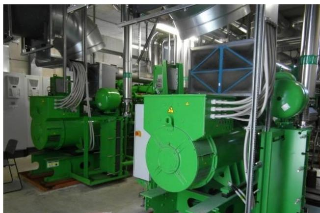
Figura 9 Sistema recupero calore dai fumi
