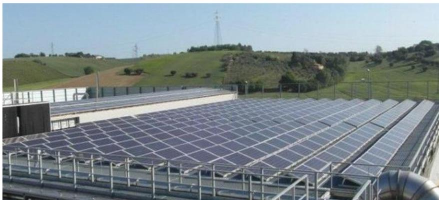
Inoltre, un impianto fotovoltaico di potenza pari a 176 kW, a terra nel piazzale adiacente al vecchio impianto di compostaggio e sulla copertura dell'edificio di miscelazione e raffinazione finale, concorre ulteriormente alla
