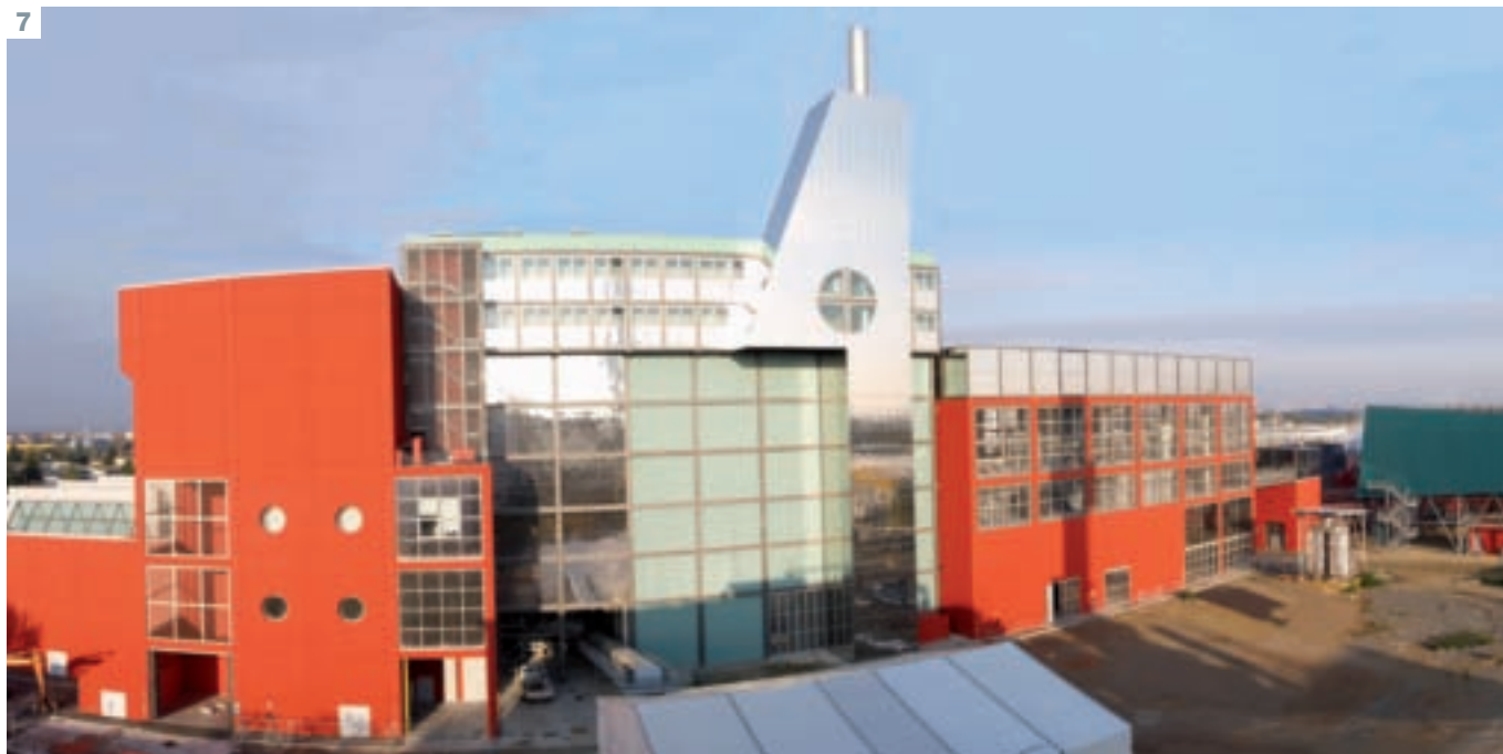
7 - Impianto di termovalorizzazione di Forlì / Forlì plant
