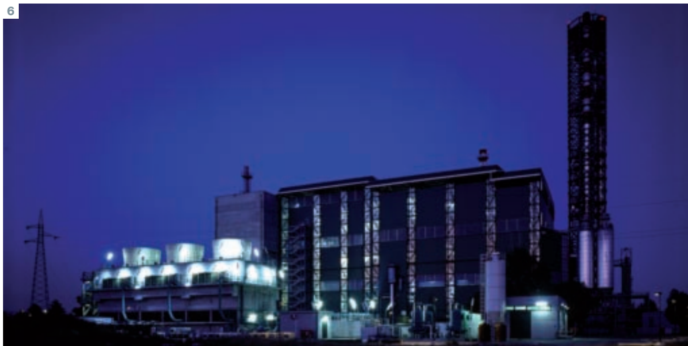
6 - Impianto di termovalorizzazione Bologna / Bologna plant
