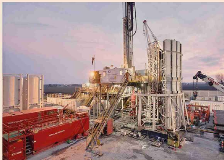
Ferrara. Lavori in corso per un nuovo pozzo alla centrale geotermica di Casaglia
