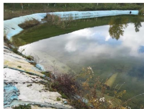
Figura 10 Laghetto di raccolta acque meteoriche
