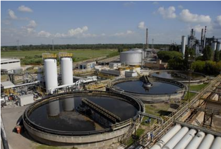
Figura 16 Vasche di sedimentazione
