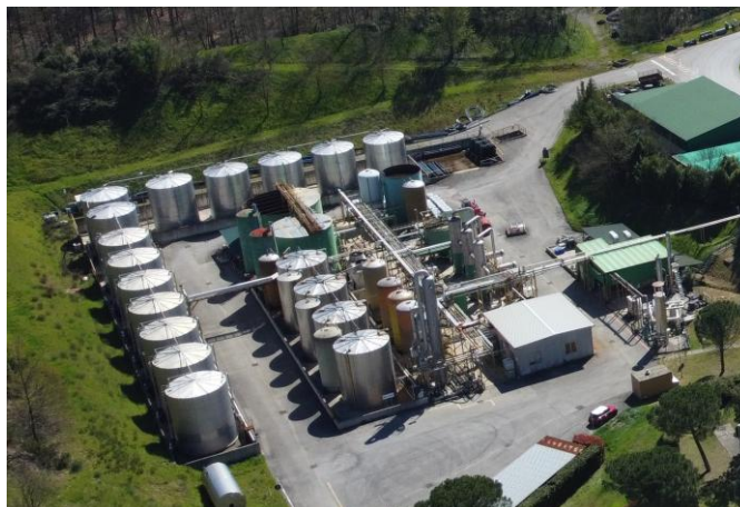
Figura 12 Vista dell'impianto di trattamento
