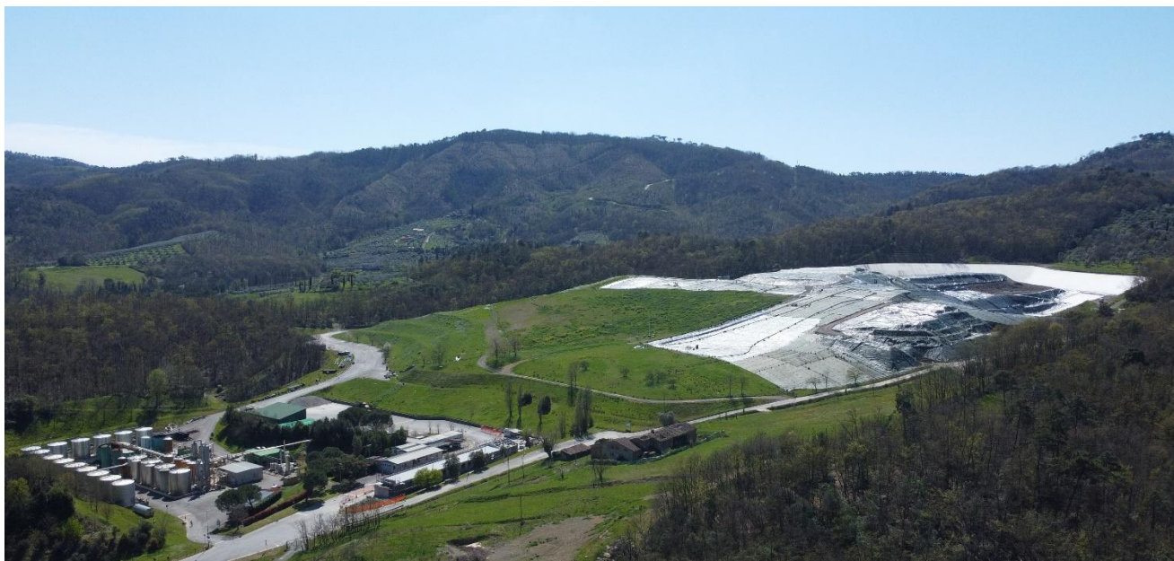
Figura 5 Vista dall'alto del sito impiantistico
