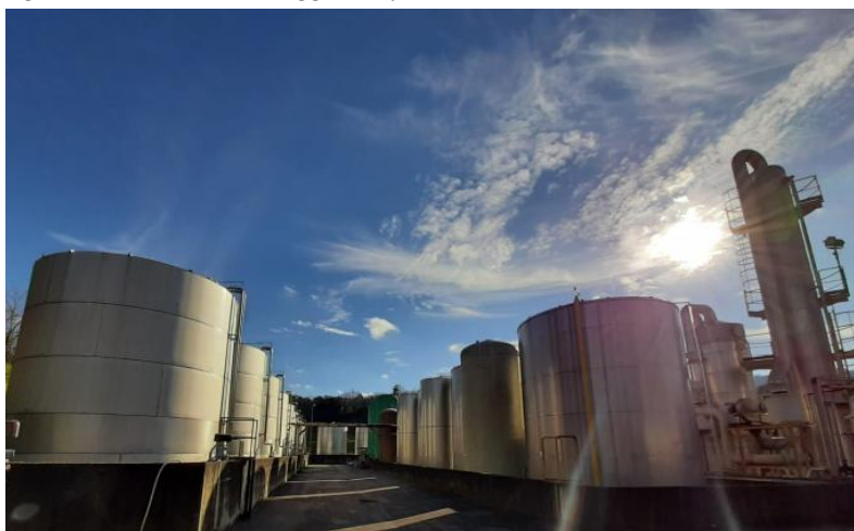
Figura 9 Serbatoi di stoccaggio del percolato
