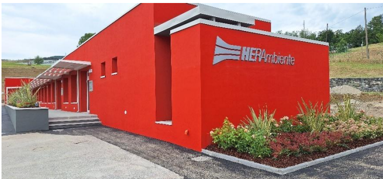
Figura 4 Particolare dell'area di accettazione e ingresso sito impiantistico
