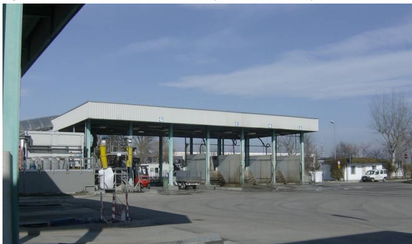
Figura 7 Area di scarico della sezione di separazione solido-liquido
