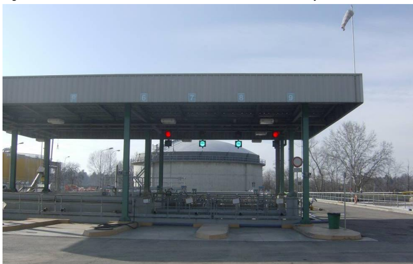
Figura 8 Area di scarico della sezione di trattamento chimico-fisico
