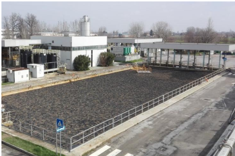
Figura 15 Vasca di sedimentazione primaria
