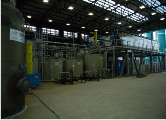
Figura 21 Sezione di filtropressatura
