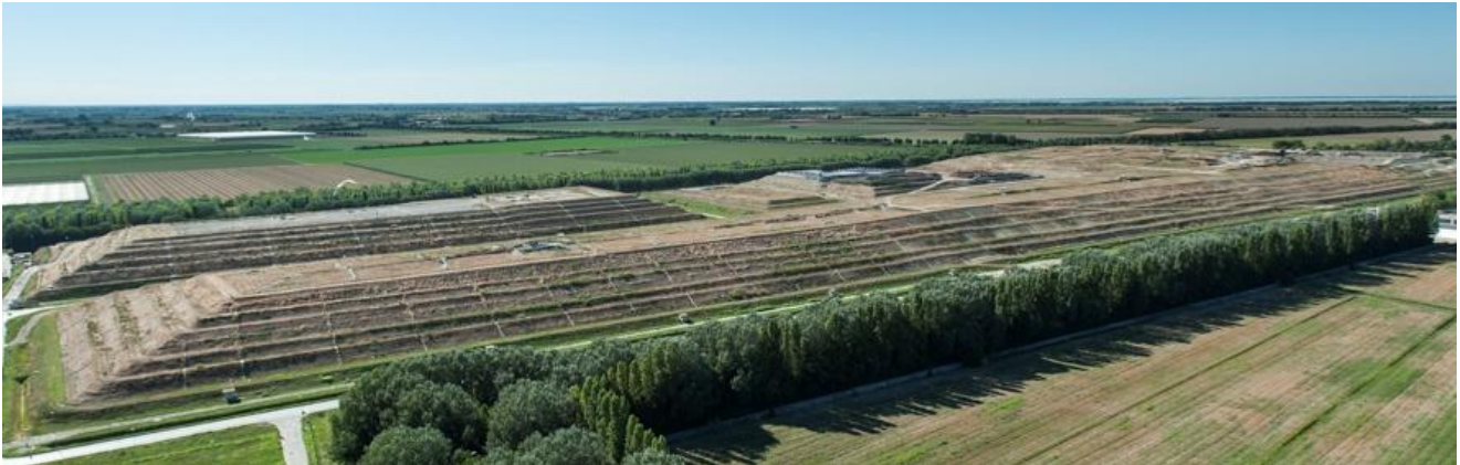
Figura 5 Vista discariche Comparto da Est
