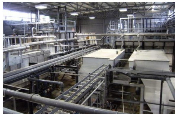
Figura 16 Particolare sezione di trattamento chimico-fisico (1° e 2° stadio)
