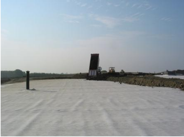
Figura 6 Operazioni di copertura definitiva
