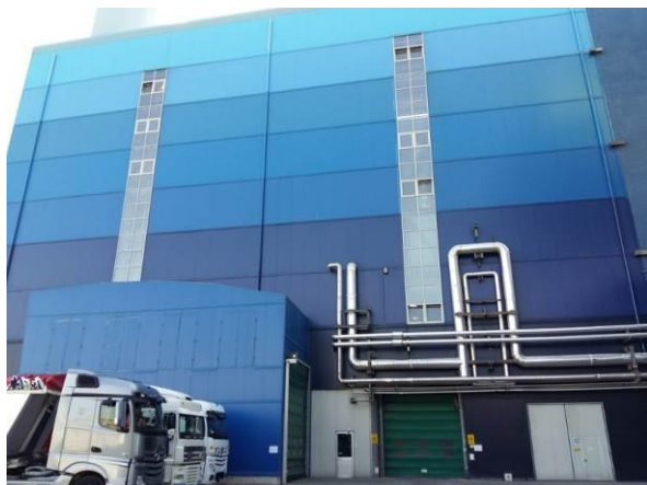
Figura 42 Particolare dell'area di scarico polverini
