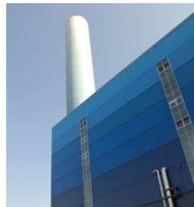
Figura 11 Particolare del camino
