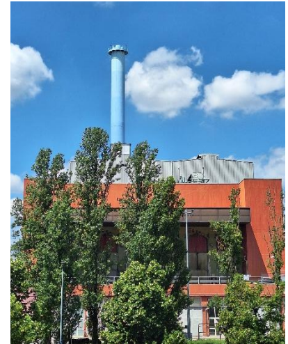
Figura 9 Camino del termovalorizzatore
