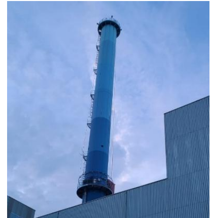
Figura 19 Camino del termovalorizzatore
