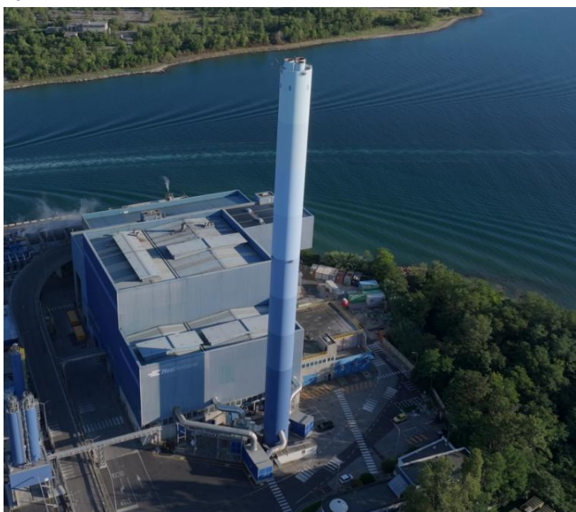
Figura 13 Camino del termovalorizzatore di Trieste
