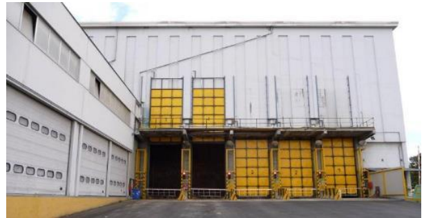
Figura 13 Visione frontale della fossa ausiliaria
