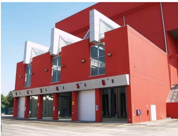
Figura 6 Particolare dell'avanfossa del termovalorizzatore
