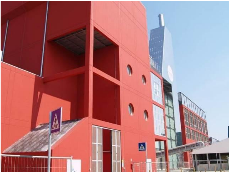
Figura 44 Facciata est con nastro di trasporto scorie
