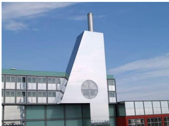
Figura 10 Particolare del camino dell'impianto
