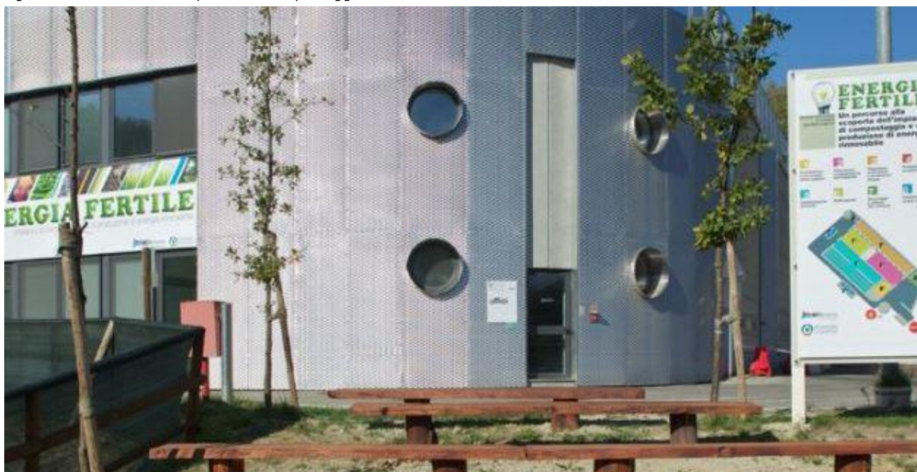
Figura 1 Particolare dell'impianto di compostaggio
