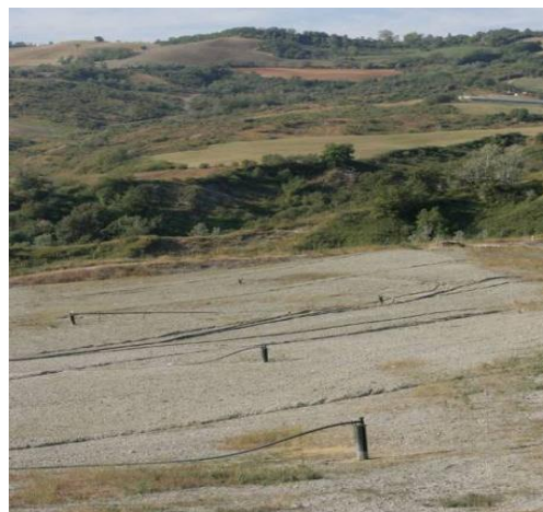
Figura 23 Sistema di estrazione del biogas
