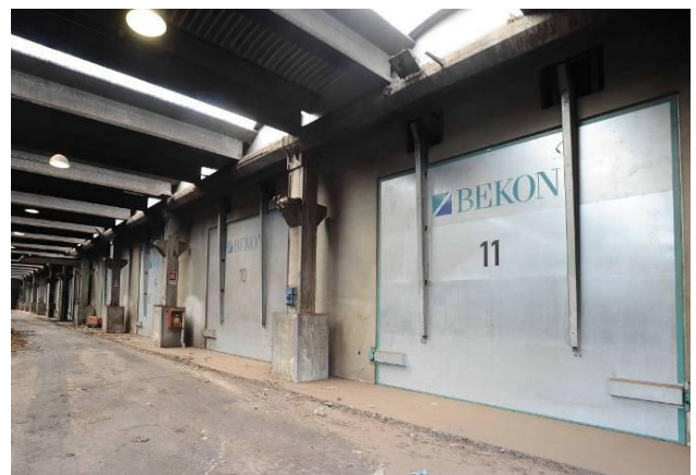
Figura 8 Digestori
