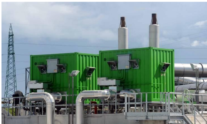
Figura 32 Punti di emissione cogeneratori (E5, E6)
