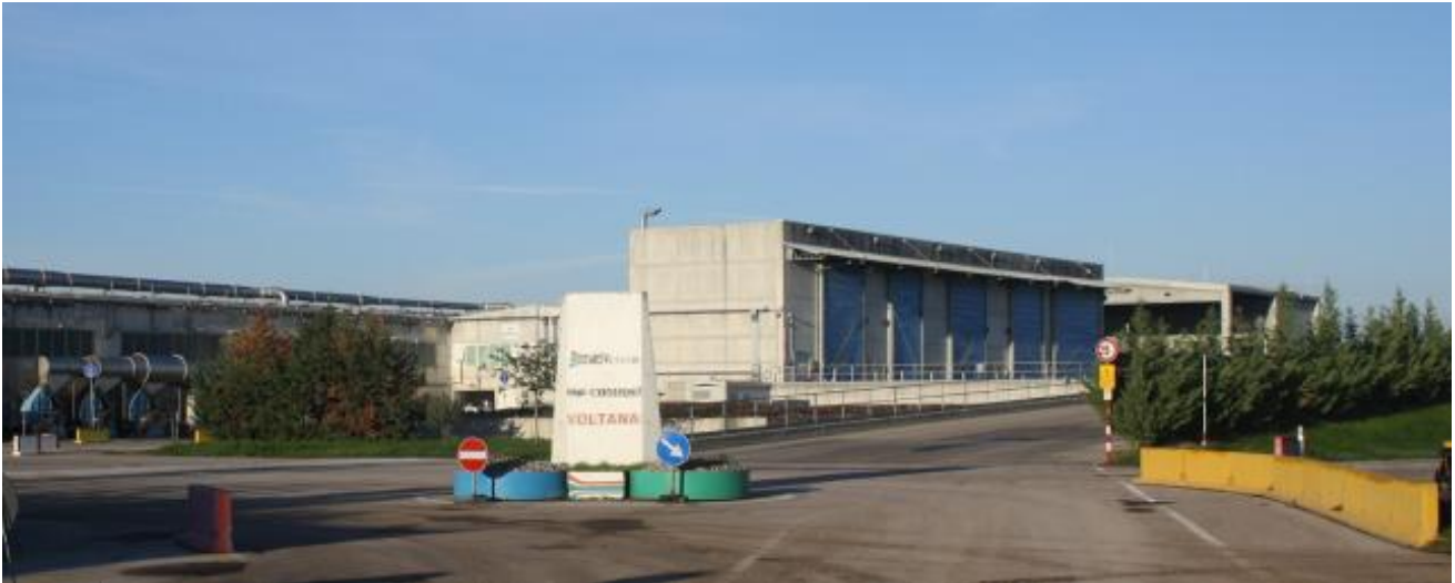
Figura 5 Vista dell'impianto di compostaggio
