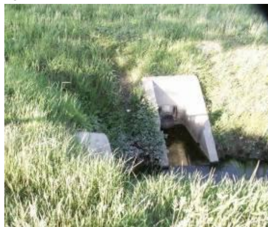
Figura 51 Punto di scarico S1/B
