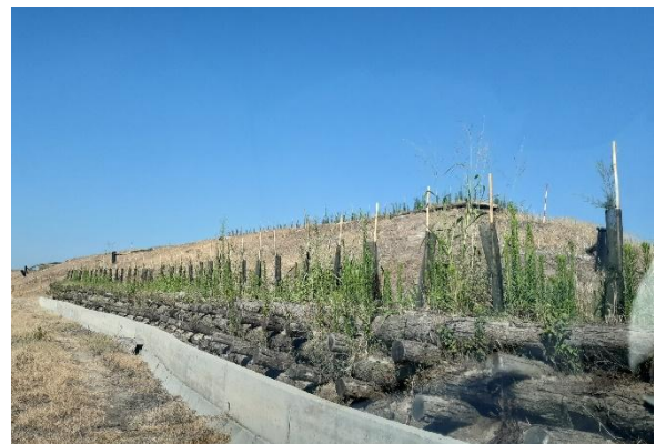
Figura 32 Particolare delle "pareti krainer"
