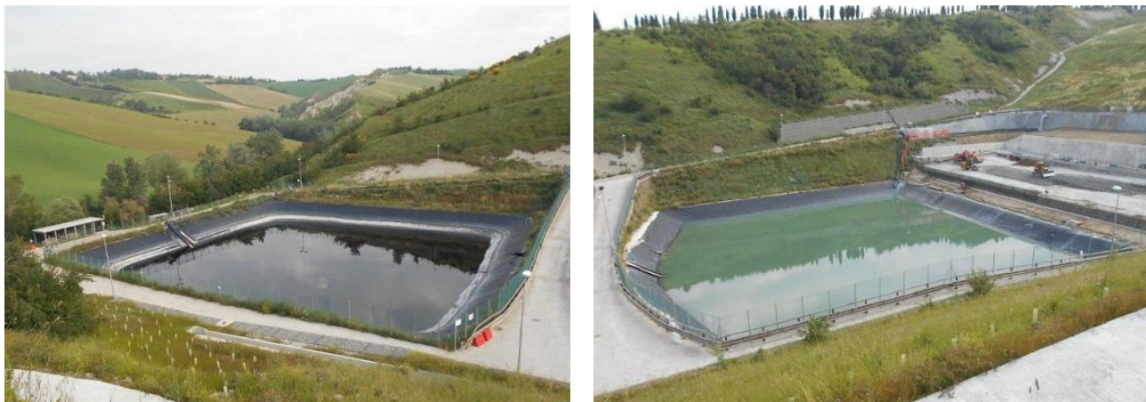
Figura 20 Vasche di stoccaggio percolato (V4 e V3)
