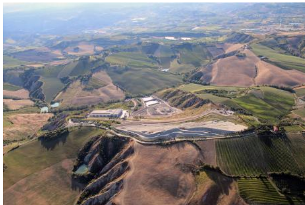
Figura 42 Foto del sito
