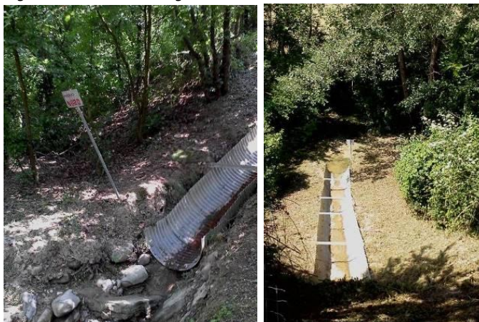
Figura 35 Particolari degli scarichi S2A e S2B
