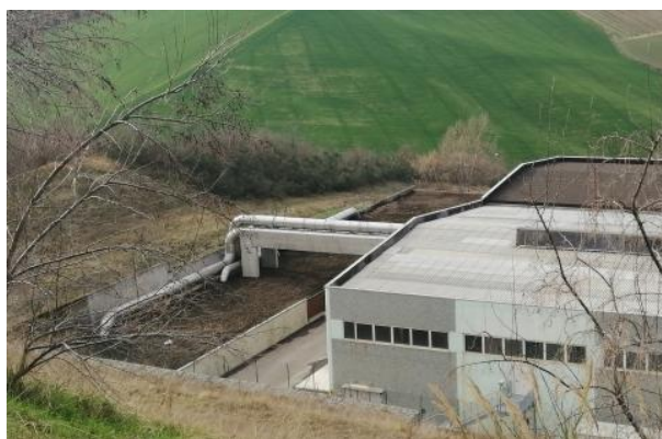
Figura 38 Biofiltro
