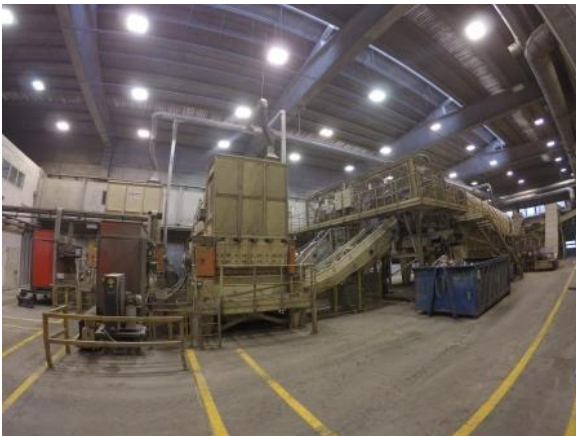
Figura 11 Impianto di tritovagliatura
