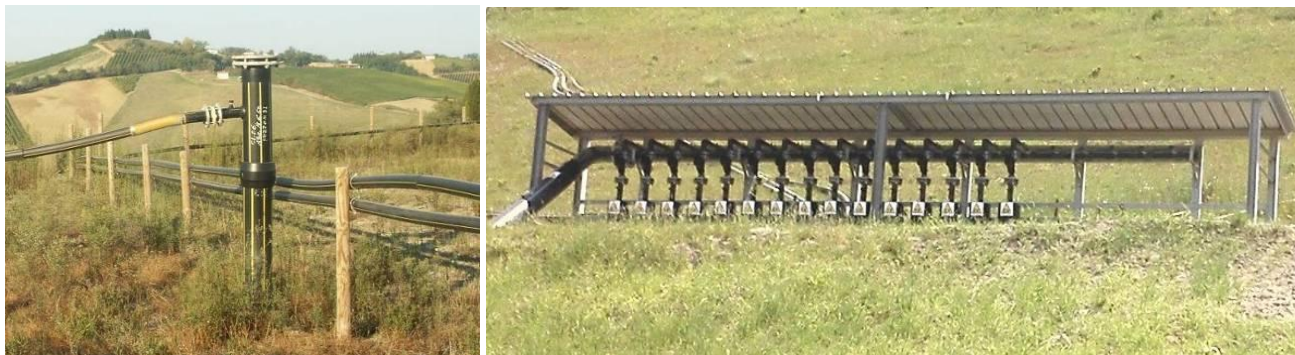
Figura 22 Testa di pozzo e Sottostazione in cui convergono le condotte di captazione del biogas
