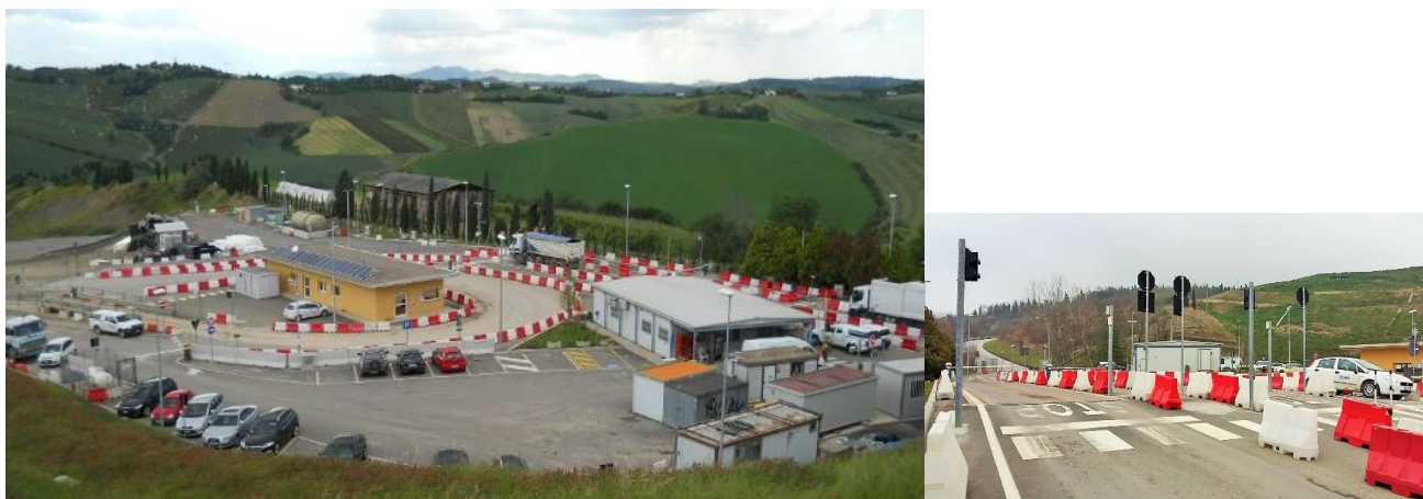
Figura 6 Veduta del Servizio di accettazione
