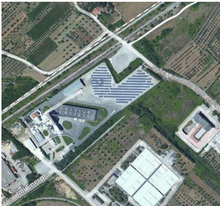
Figura 2 Vista area del sito impiantistico
