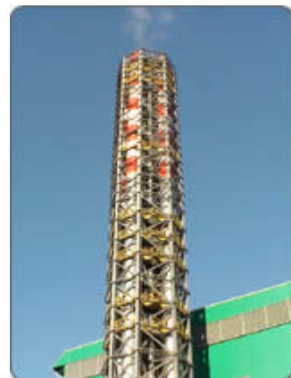
SISTEMA DI MONITORAGGIO FUMI IN CONTINUO
