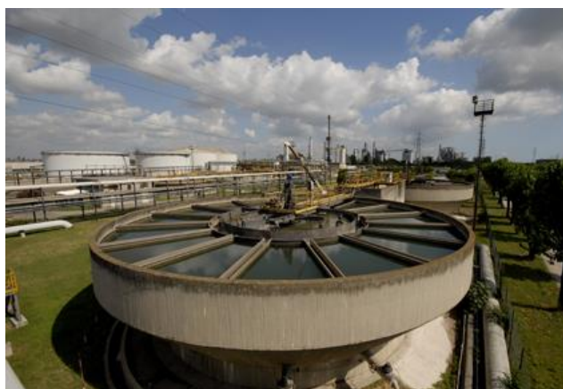
Figura 19 Chiarificatore accelerato
