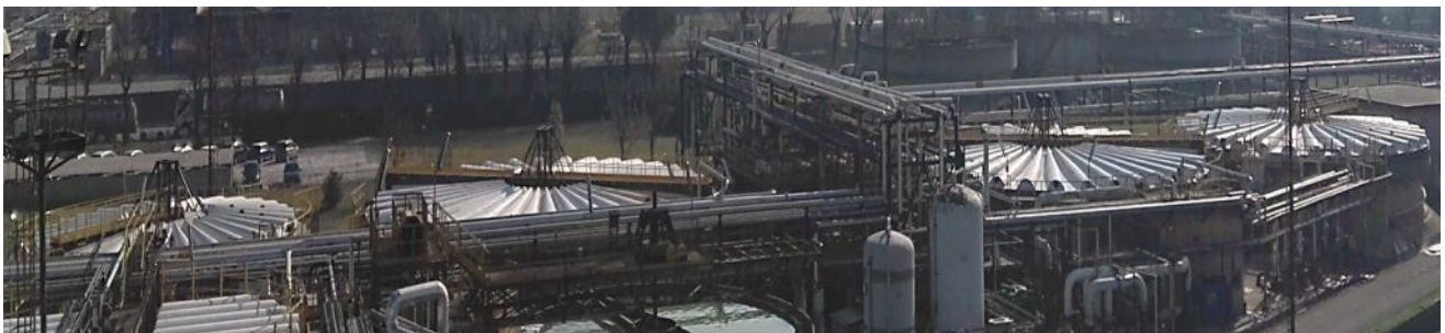
Figura 15 Particolare del trattamento primario
