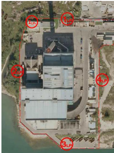
Figura 26: Punti di misura al limite della proprietà
