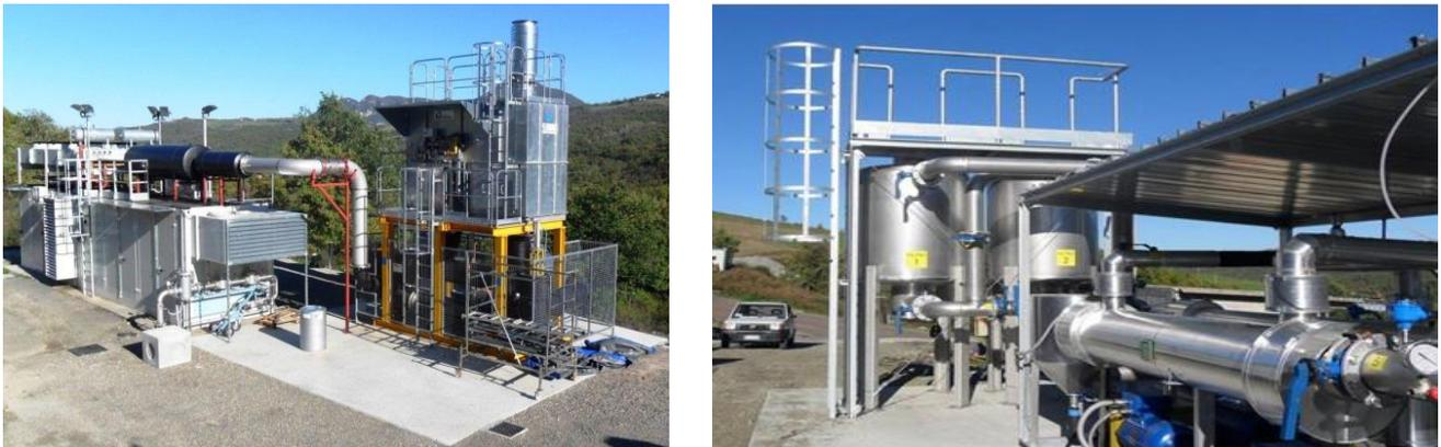
Oltre alla gestione e manutenzione ordinaria del motogeneratore, sistema di estrazione del gas e torcia, il personale esegue periodicamente il monitoraggio del biogas estratto attraverso uno strumento portatile, misurando ossigeno, metano, CO<sub>2</sub> e depressione su ogni SDR (Sottostazione di Regolazione), per regolare al meglio la depressione sui pozzi al fine di ottenere la massima resa di sfruttamento e di estrazione del biogas e quindi del suo recupero energetico.
