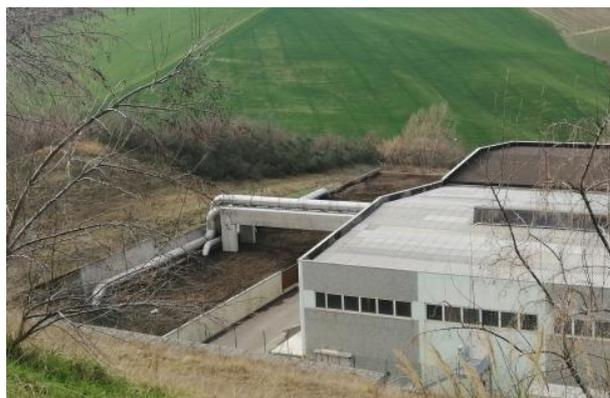
è un sistema di ossidazione biologica delle molecole odorigene, tramite il quale i prodotti ossidati sono caratterizzati da odorsità nulla o decisamente bassa. Le sostanze odorigene sono fermate da un letto filtrante, costituito da legno cippato, e ossidate ad anidride carbonica ed acqua dall'attività dei microorganismi qui insediatisi.
