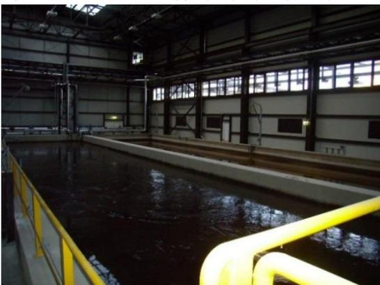
Nella vasca di stoccaggio in ingresso, i fanghi vengono omogeneizzati e trasferiti o alla sezione di lavorazione dei fanghi palabili (linea di inertizzazione/condizionamento), che costituisce la destinazione prevalente di questa tipologia di fanghi, che verrà di seguito descritta, oppure alla linea di condizionamento/filtropressatura, per cui si rimanda alla linea dei fanghi pompabili, precedentemente esposta.
