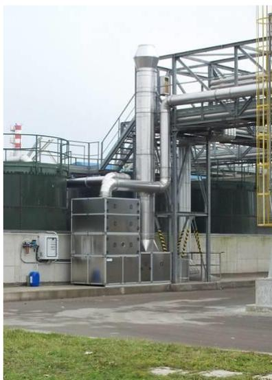
Il sistema di abbattimento è sottoposto regolarmente a manutenzione, come prescritto da atto autorizzativo, e almeno annualmente vengono monitorati gli effluenti in uscita dal filtro.
