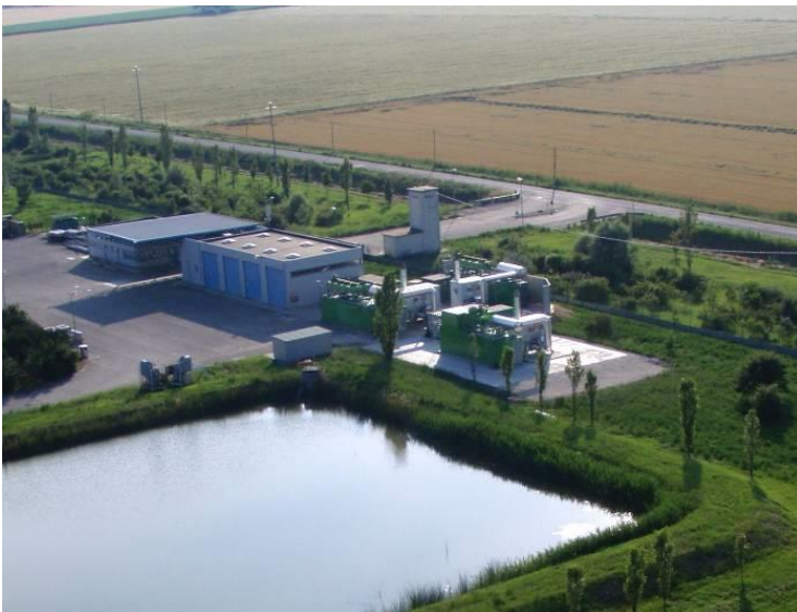
Figura 14 Impianto di produzione di energia elettrica
