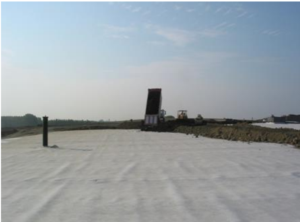
Figura 7 Operazioni di copertura definitiva
