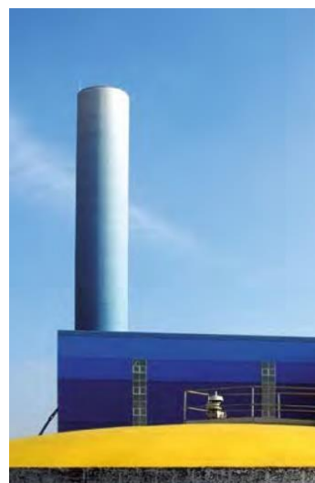
Figura 29 Particolare del punto di emissione E4/a
