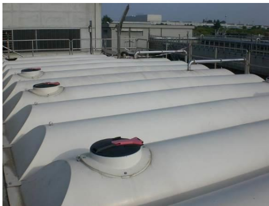
Figura 35 Copertura vasca di stoccaggio VP
