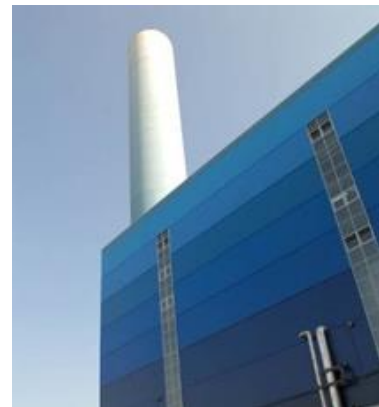
Figura 11 Particolare del camino
