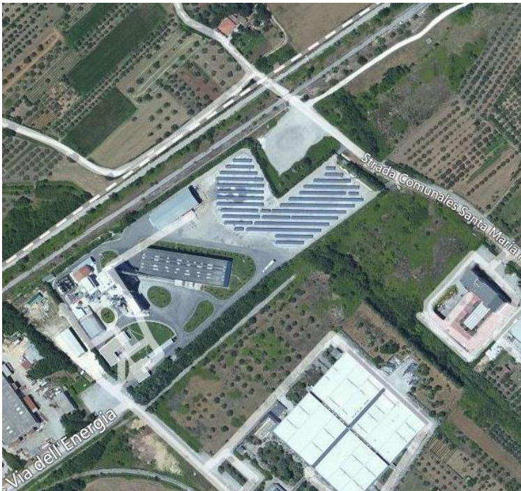
Figura 2 Vista area del sito impiantistico
