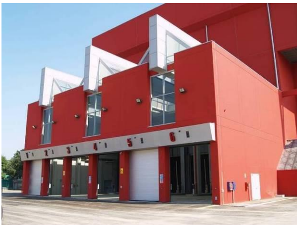
Figura 7 Particolare dell'avanfossa del termovalorizzatore
