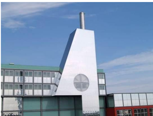
Figura 11 Particolare del camino dell'impianto
