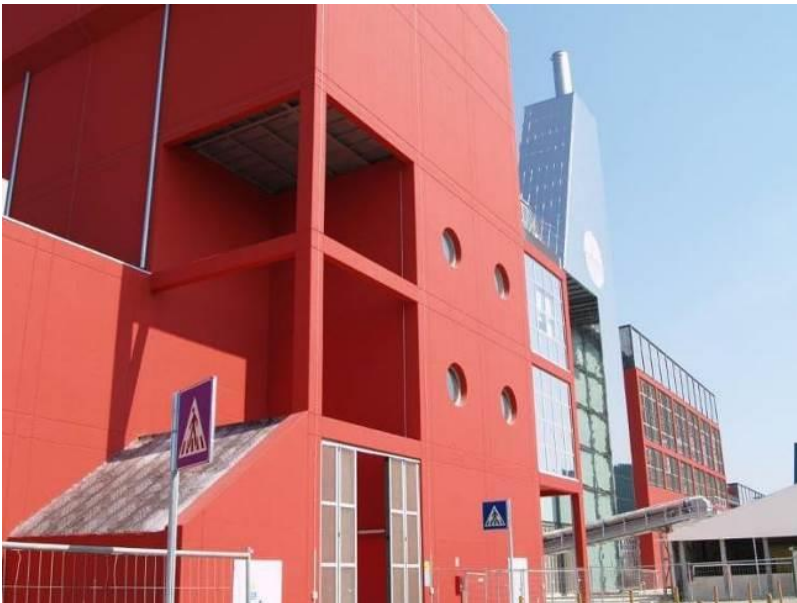
Figura 45 Facciata est con nastro di trasporto scorie
