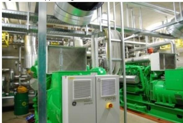
L'energia elettrica prodotta viene immessa in rete mentre il calore viene recuperato e utilizzato per il riscaldamento dei digestori anaerobici, del serbatoio di accumulo del percolato e dei locali adibiti ad ufficio; inoltre viene utilizzato, a seconda delle necessità del processo, per il riscaldamento dell'aria introdotta nella sezione aerobica.
