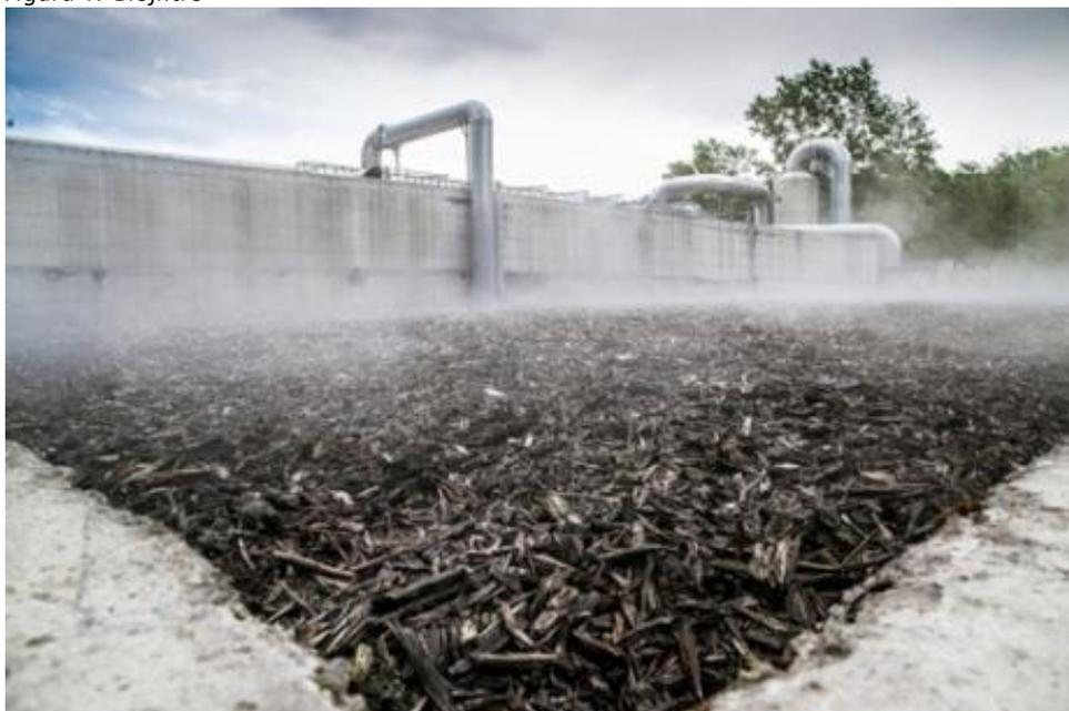
La biofiltrazione è un sistema di ossidazione biologica delle molecole odorigene, tramite il quale i prodotti ossidati sono caratterizzati da odosità nulla o decisamente bassa. Le sostanze odorigene sono fermate da un letto filtrante, costituito da legno cippato, e ossidate ad anidride carbonica ed acqua dall'attività dei microorganismi qui insediatisi.
