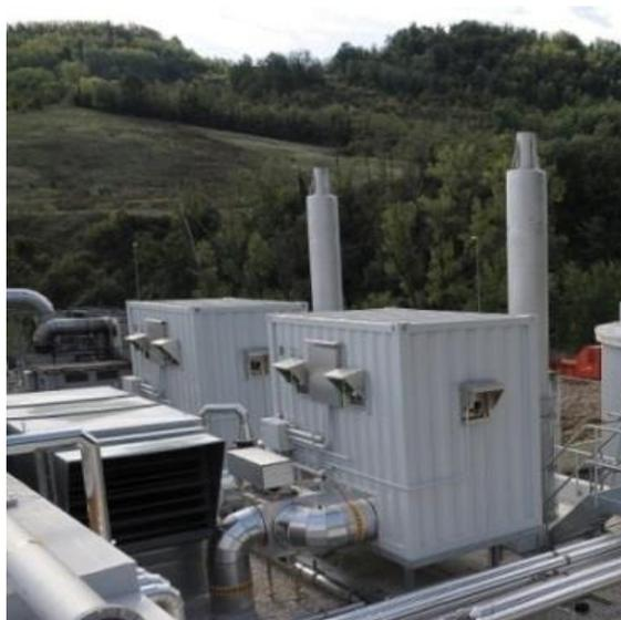
L'impianto di compostaggio presenta, inoltre, due punti di emissioni convogliate, E4 e E5, connessi al sistema di digestione anaerobica e relativo impianto di cogenerazione (Figura 49). Il combustibile impiegato è il biogas che si sviluppa dalla fase di digestione anaerobica dei rifiuti ed in minima parte dalla vasca di stoccaggio del percolato di processo. Per l'abbattimento degli inquinanti è presente un post-combustore con tecnologia CL.AIR.
