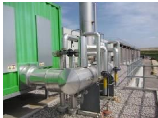
Figura 11 Sistema recupero calore dai fumi
