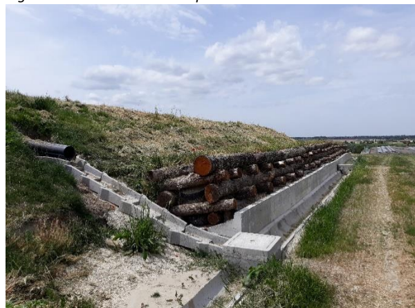
Figura 31 Particolare delle "pareti krainer"
