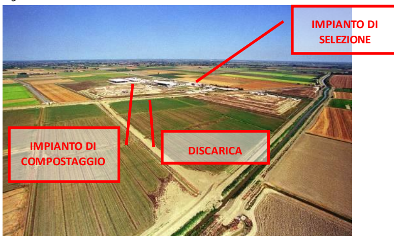
Figura 67 Foto del sito
