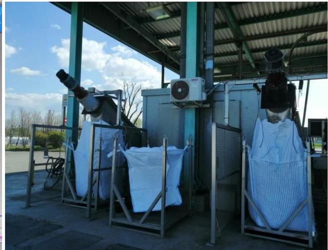
I sacchi contenenti le sostanze solide estratte, una volta riempiti, vengono depositati nel piazzale esterno di disidratazione e stoccaggio, dotato di un sistema di raccolta delle acque meteoriche e di percolazione collegato, tramite pompaggio, alla linea di separazione solido – liquido.
