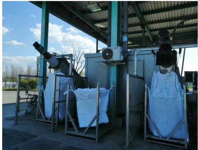
I sacchi contenenti le sostanze solide estratte, una volta riempiti, vengono depositati nel piazzale esterno di disidratazione e stoccaggio, dotato di un sistema di raccolta delle acque meteoriche e di percolazione collegato, tramite pompaggio, alla linea di trattamento chimico-fisico.
