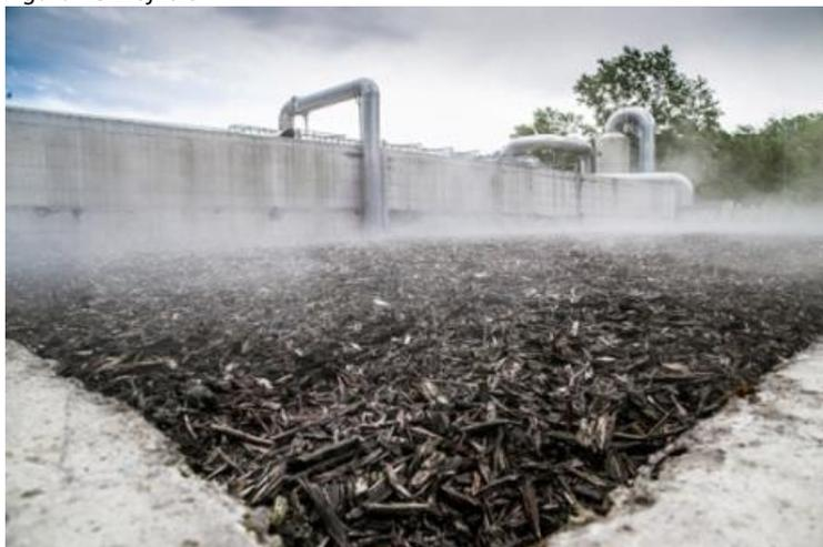
La biofiltrazione è un sistema di ossidazione biologica delle molecole odorigene, tramite il quale i prodotti ossidati sono caratterizzati da odorsità nulla o decisamente bassa. Le sostanze odorigene sono fermate da un letto filtrante, costituito da legno cippato, e ossidate ad anidride carbonica ed acqua dall'attività dei microorganismi qui insediatisi.
