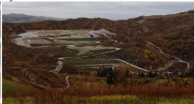
La discarica è stata autorizzata con Delibera G.P. n. 527 del 18/02/2012 per un volume complessivo di 1.500.000 m<sup>3</sup> e, al 31/12/2012, la volumetria occupata era pari a circa 1.158.000 m<sup>3</sup>, calcolata da rilievo topografico. L'impianto ha ricevuto prevalentemente i rifiuti di provenienza urbana, in particolare, rifiuti provenienti da impianti di trattamento e selezione (es. scarti degli impianti di compostaggio e di selezione rifiuti).
