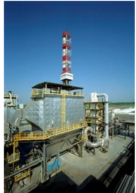
Figura 11 Sezione di depurazione fumi (F3)
