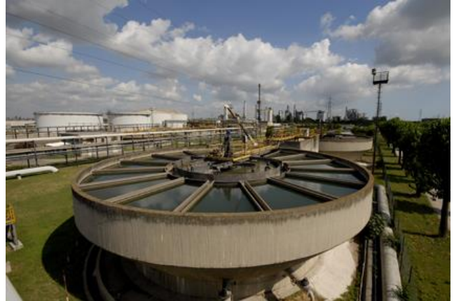
Figura 19 Chiarificatore accelerato
