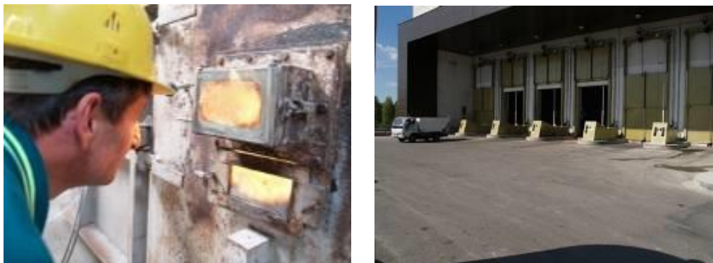
Figura 8 Finestra di controllo della camera di combustione e portoni di accesso alla fossa principale
