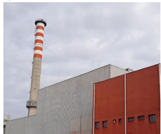
Figura 20 Camino del termovalorizzatore
