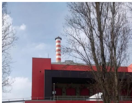
Figura 9 Camino del termovalorizzatore
