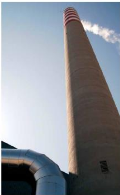
Figura 13: Camino del termovalorizzatore di Trieste
