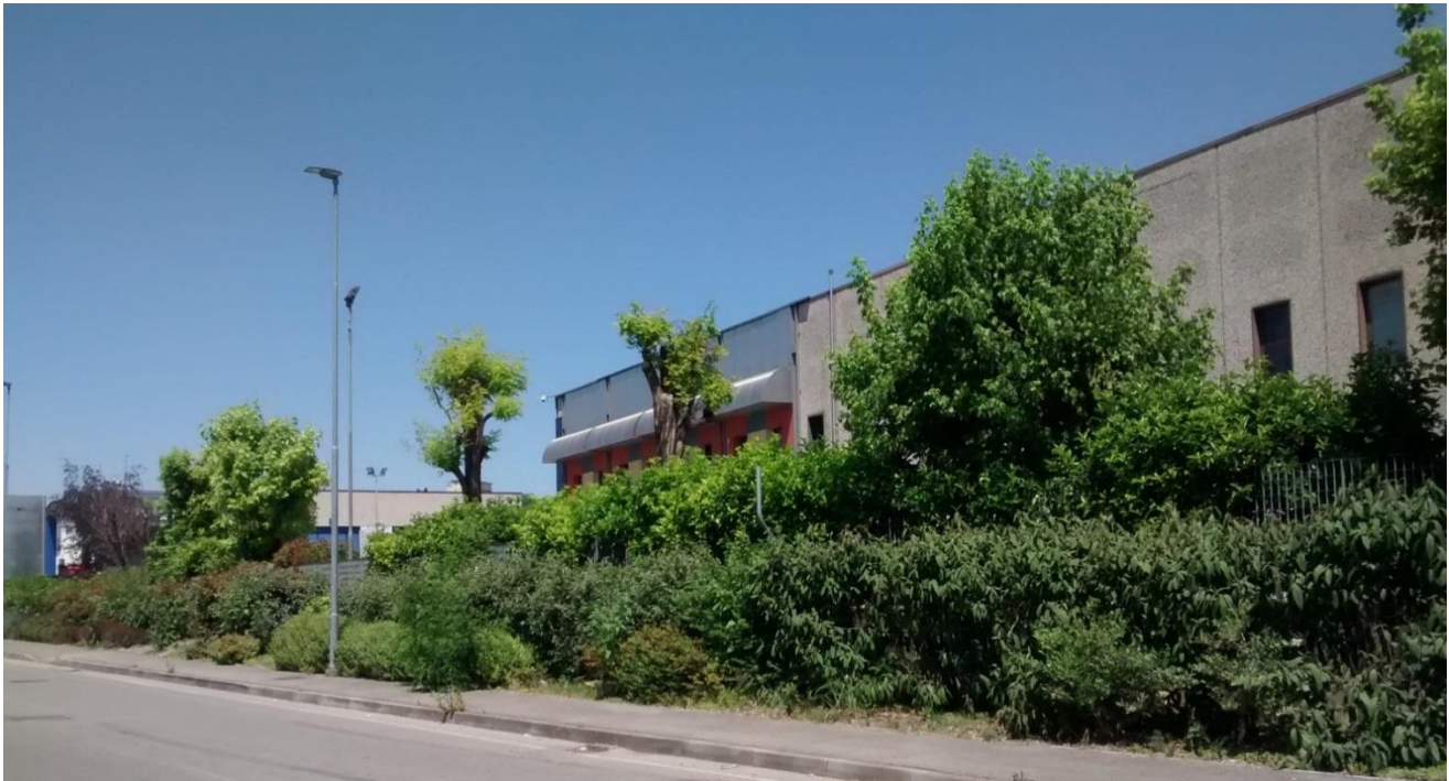
Figura 1 Vista esterna dell'Impianto
