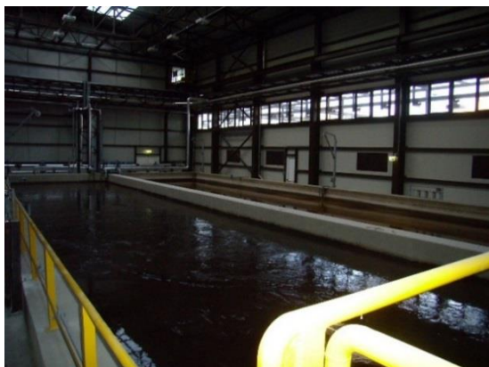
Figura 26 Vasca di stoccaggio fanghi pompabili pericolosi
