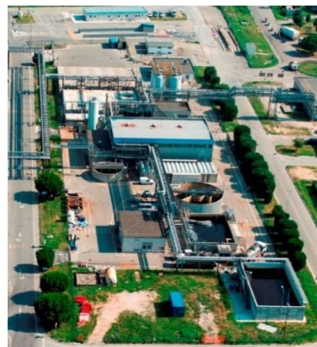
Figura 16 Impianto trattamento chimico-fisico
