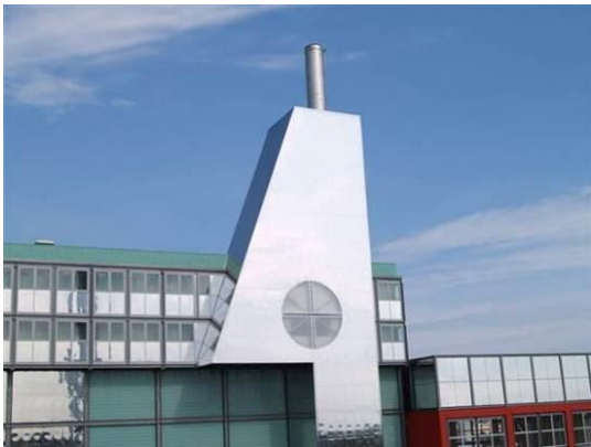
Figura 11 Particolare del camino dell'impianto
