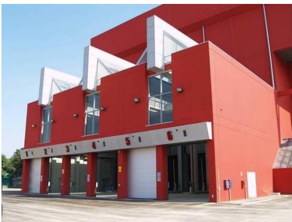
Figura 7 Particolare dell'avanfossa del termovalorizzatore
