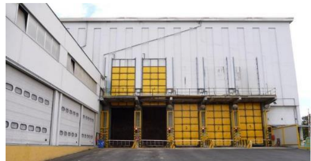
Figura 14 Visione frontale della fossa ausiliaria
