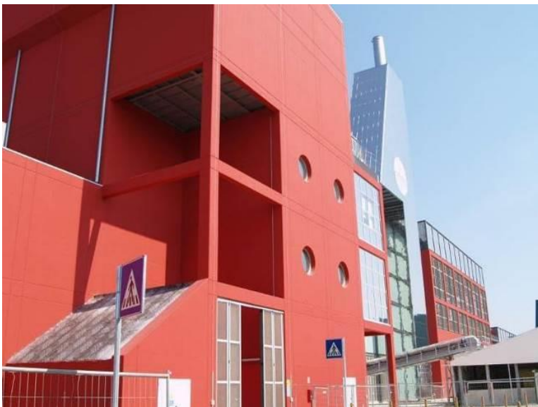
Figura 45 Facciata est con nastro di trasporto scorie
