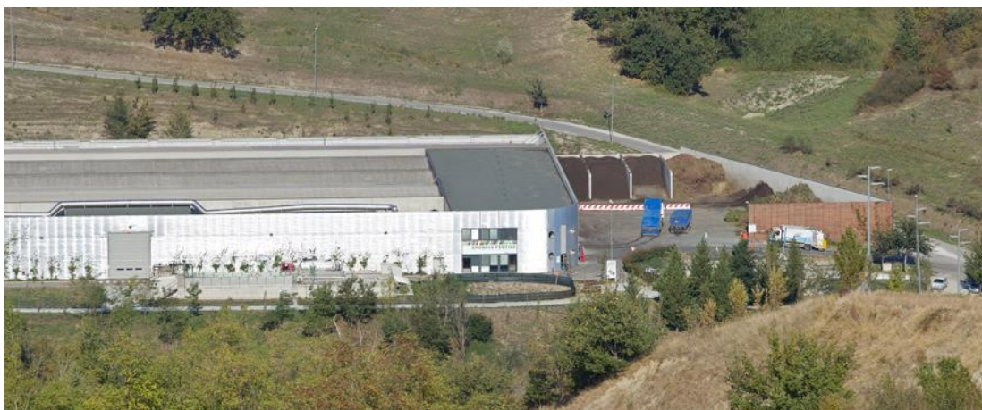
Figura 7 Vista dell'impianto di compostaggio
