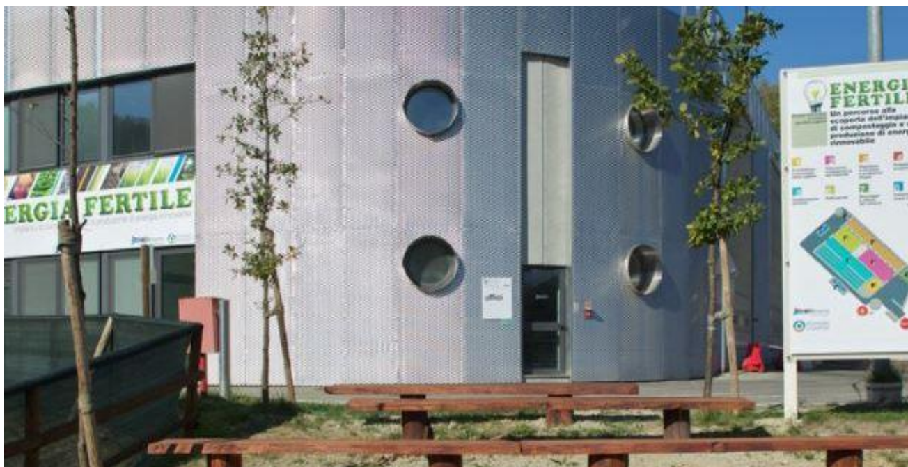
Figura 1 Particolare dell'impianto di compostaggio
