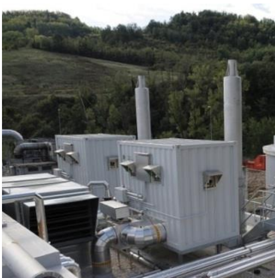
Figura 43 Punti di emissione cogeneratori (E4, E5)
