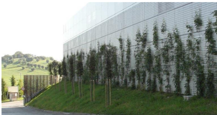
Figura 11 Area Digestione Anaerobica
