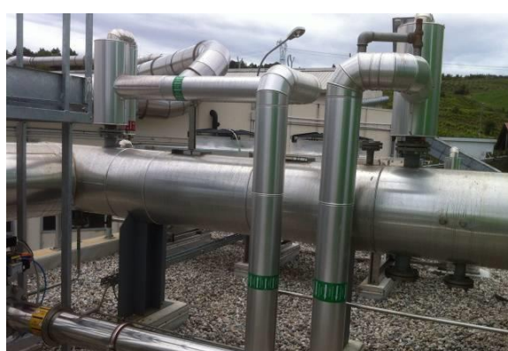
Figura 10 Sistema recupero calore dai fumi
