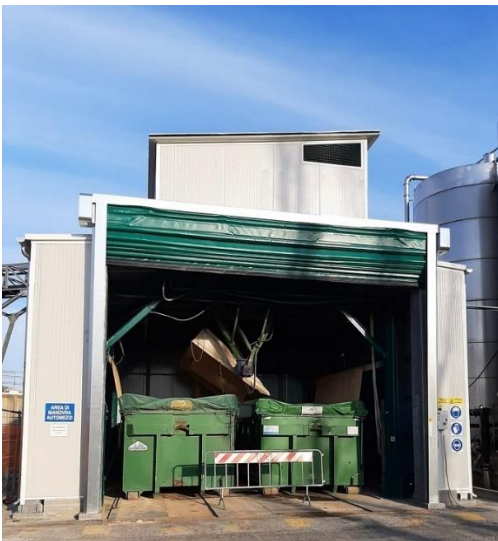
Figura 11 Particolare della filtropressa
