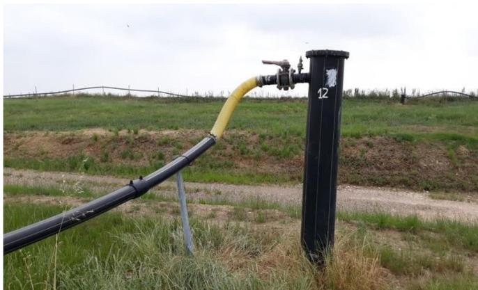
Figura 34 Torcia di combustione biogas
