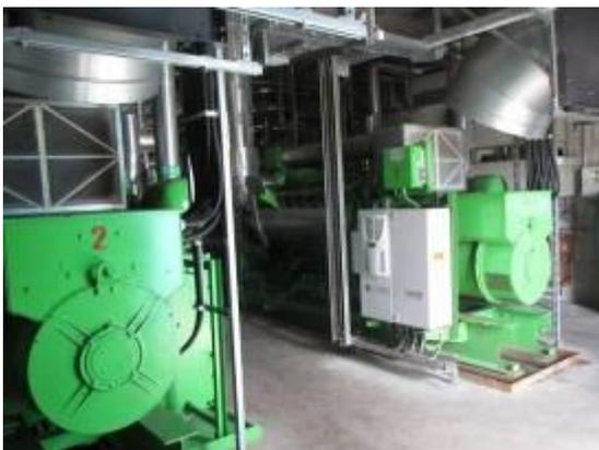
Figura 11 Sistema recupero calore dai fumi
