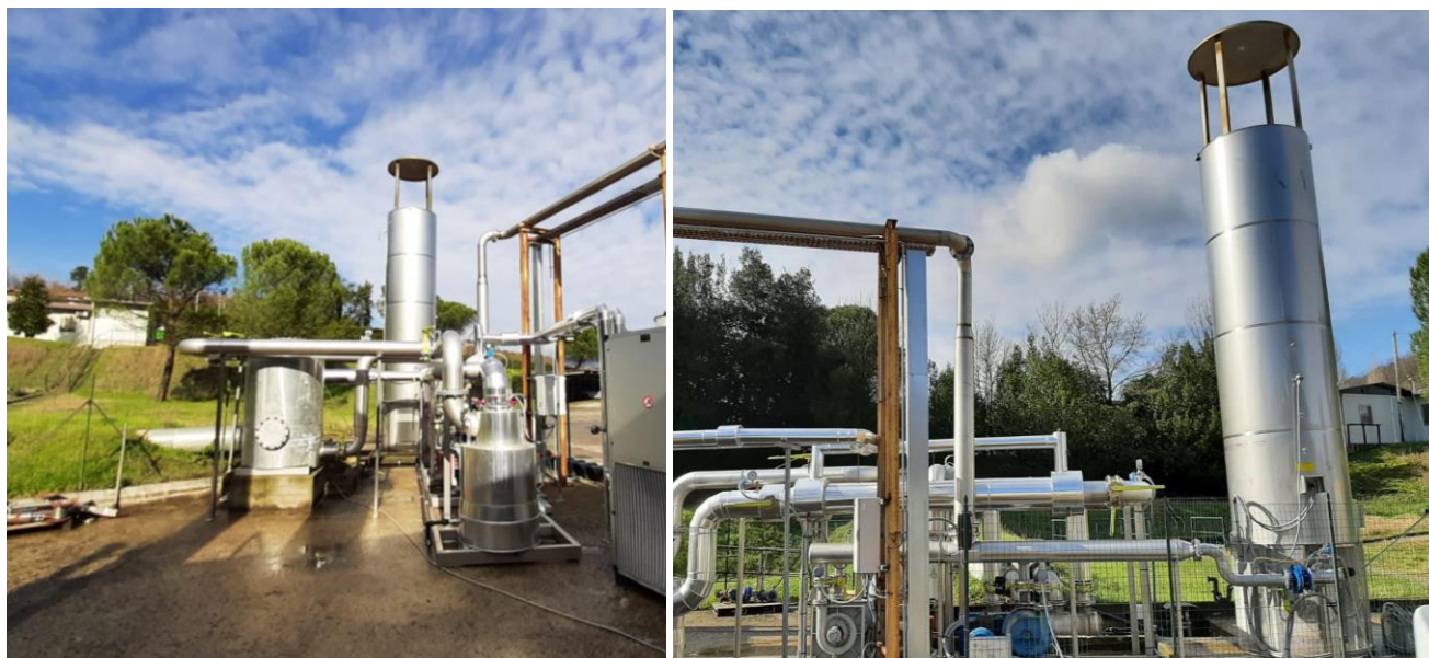
Figura 10 Particolari della nuova torcia
