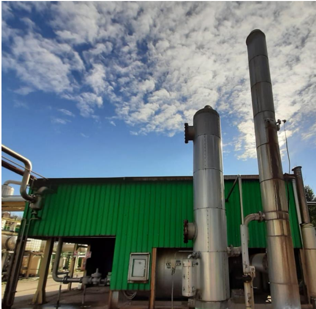
Figura 20 Particolare del punto di emissione della caldaia
