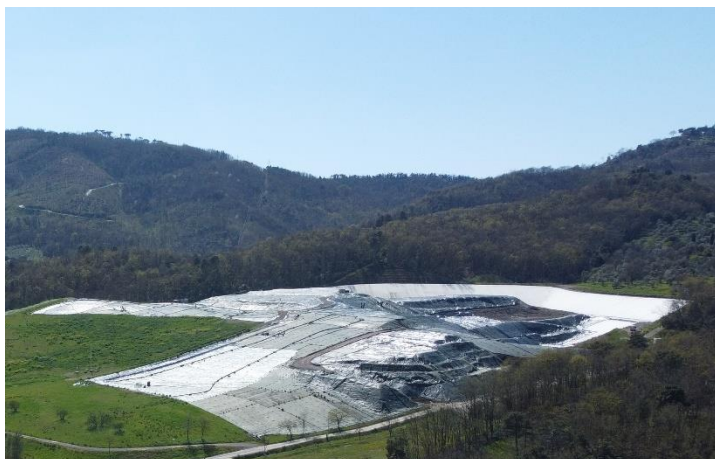
Figura 8 Vista della discarica
