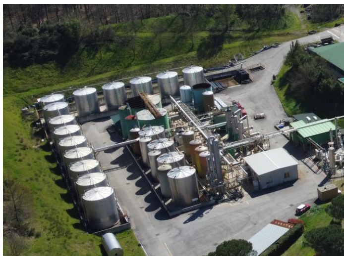
Figura 12 Vista dell'impianto di trattamento
