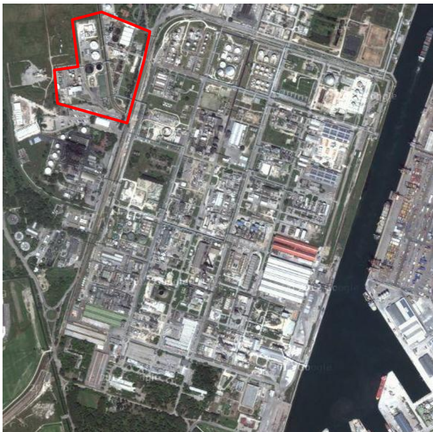
Figura 1 Distretto 2 Ravenna – In rosso è evidenziato il Centro Ecologico Baiona in adiacenza al Sito Multisocietario
