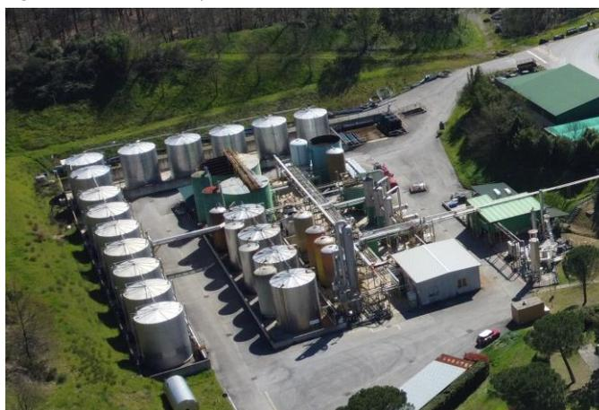
Il ciclo di trattamento prevede il recupero energetico del biogas prodotto dalla discarica utilizzato come combustibile in caldaia per produrre vapore da impiegare nella prima fase di evaporazione e coprire il fabbisogno termico dell'impianto.
