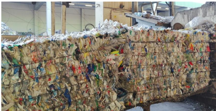
Figura 14 Particolare della pressa (L3)
