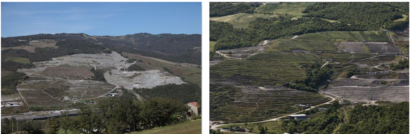
Figura 20 Immagine dell'impianto nel 2015 e immagine impianto a seguito lavori di rinaturalizzazione del versante
